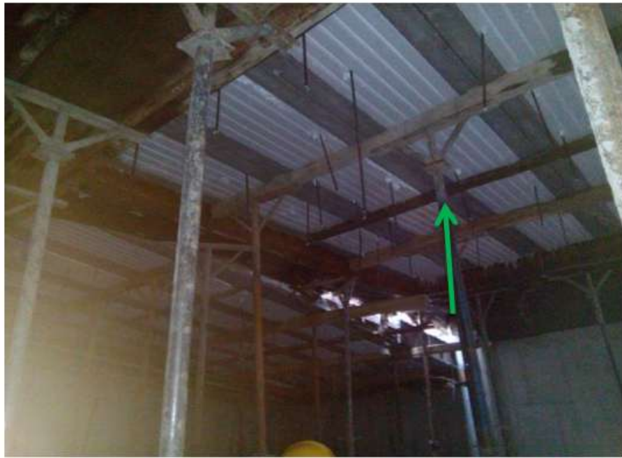
اجرای صحیح آویز برای سقف کاذب قبل از بتن ریزی سقف
