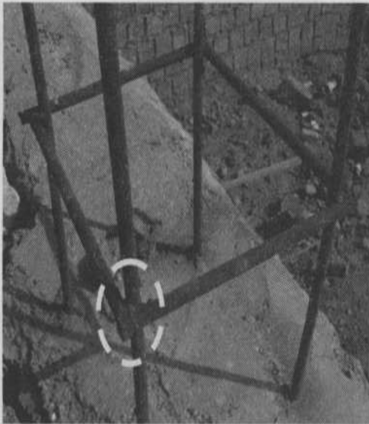
تصاویر (۱-۲۳): جوشکاری میلگردهای متقاطع باعث صدمه به میلگرد طولی شده است
