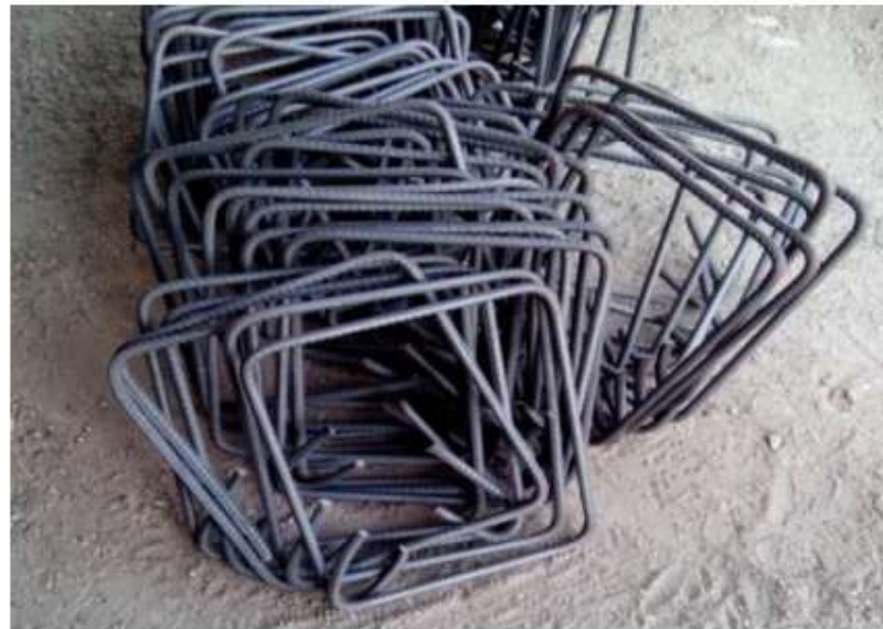
رعایت زاویه ۱۳۵ درجه خم انتهایی خاموت (برای سازه‌های با قاب خمشی ویژه)
