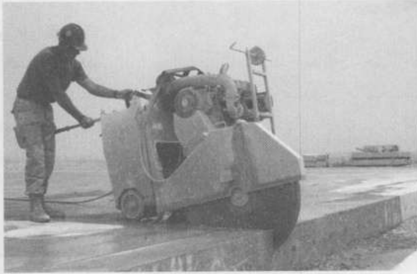
تصویر (۳-۹۸): استفاده از دستگاه برش برای ایجاد درز در بتن سخت شده
