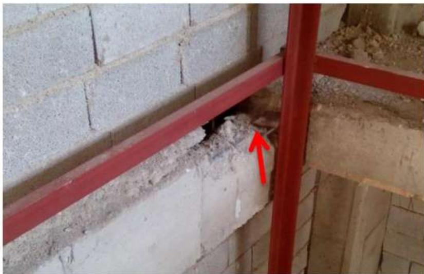
شکستن کاور تیر و گرفتن اتصال برای نبشی آسانسور
