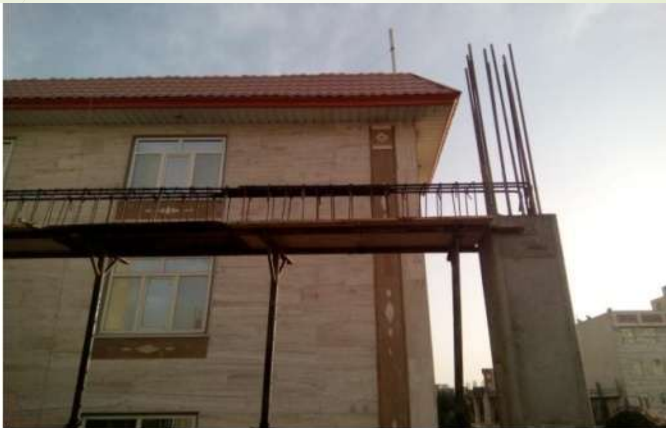
وضعیت نامناسب اتصال تیر به ستون (عدم اجرای خاموت‌های محل اتصال تیر به ستون)
