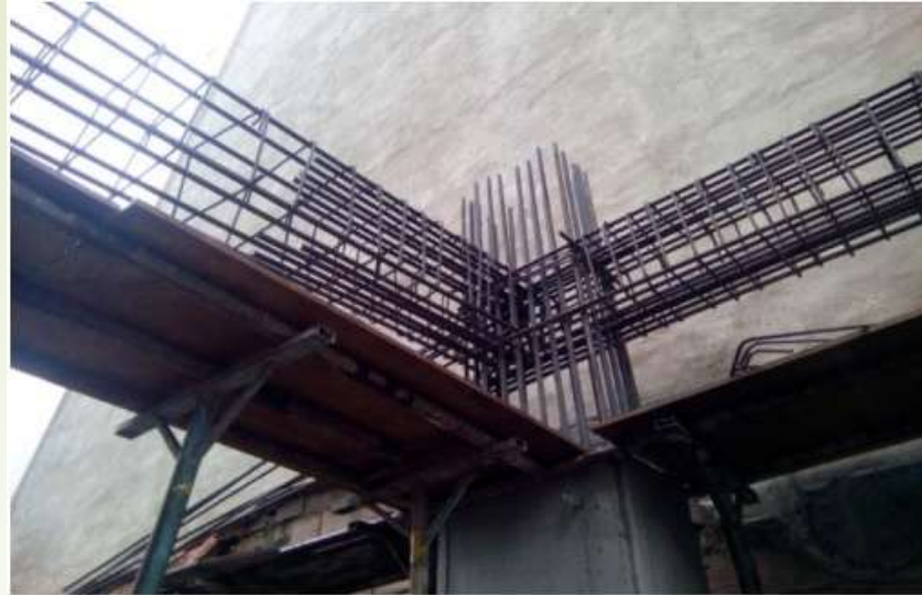
وضعیت نامناسب اتصال تیر به ستون
